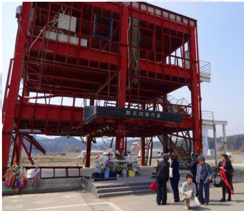
南三陸町防災対策庁舎
